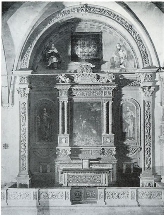
3) Chiesa di S. Martino, Cappella Boncompagni prima del restauro.
